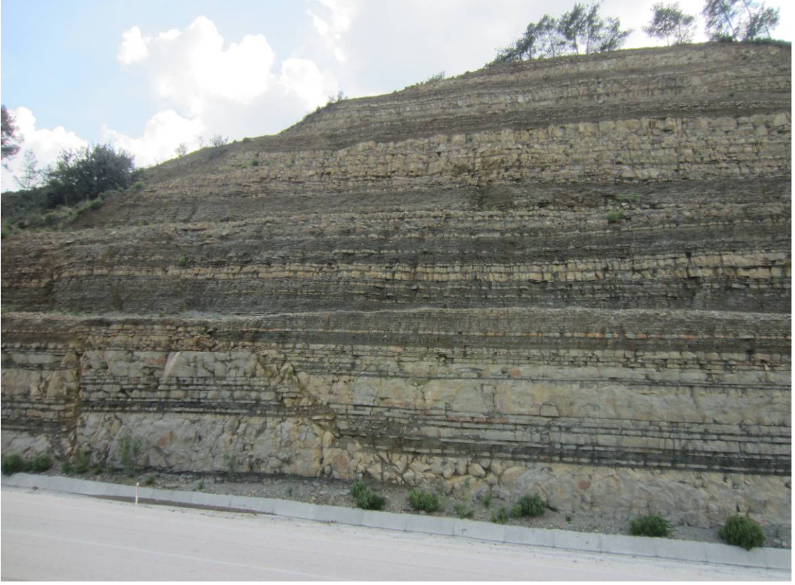
7: Cingöz F. türbidit kumtaşlarının genel görünümü, palye yapımı ve faylar (Fotoğraf 7).
