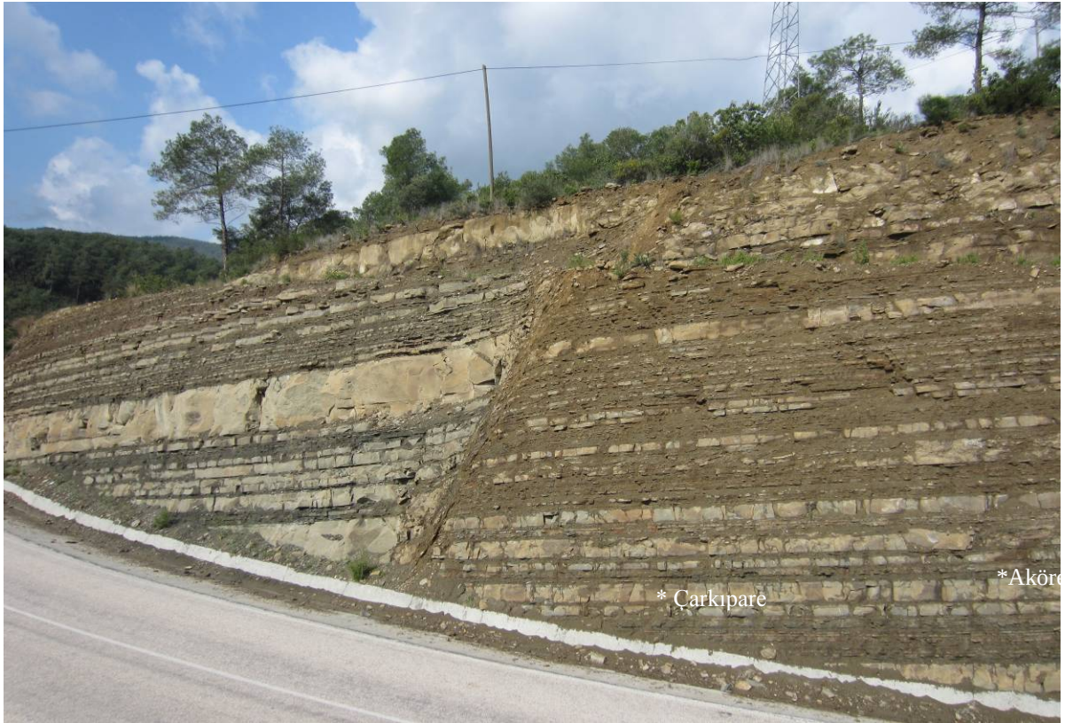
6: Cingöz formasyonu türbidit kumtaşlarının yakın görünümü.(Fotoğraf 6).
