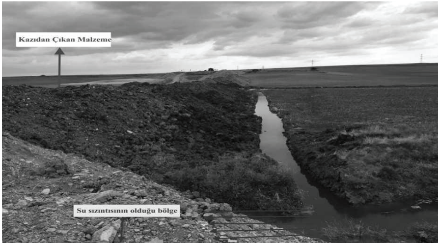
Şekil 6. Kazıdan çıkan malzemenin depolandığı alan ve sızıntısının olduğu bölge.
