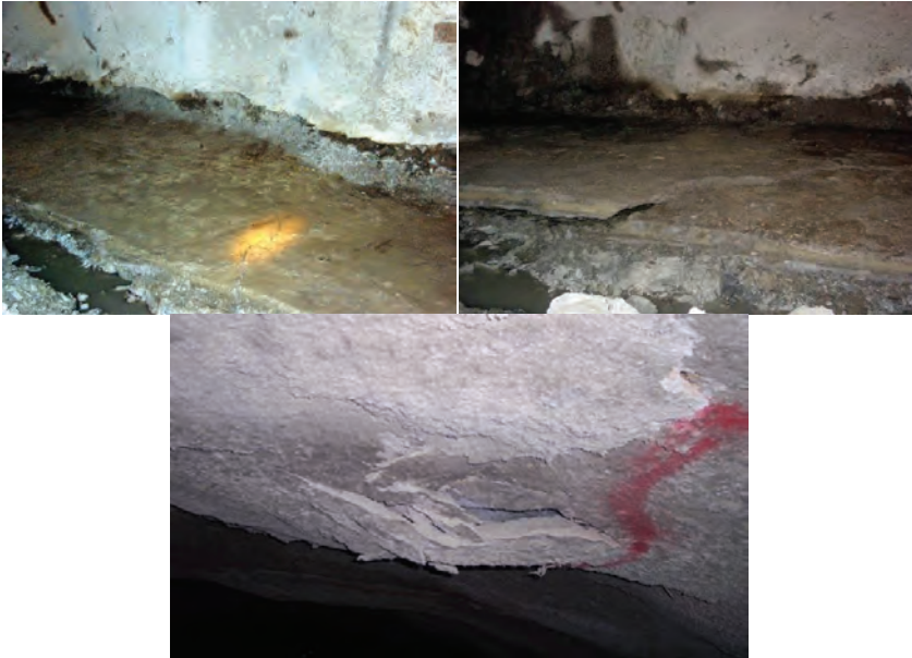
Şekil 4. Tünel inşaatı sırasında gözlenen taban kabarmaları ve dökülmeler
