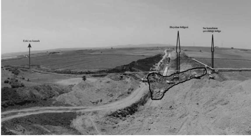
Şekil 5. Heyelan bölgesi ve su kanalının çevrildiği bölge.
