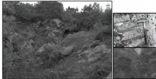
Şekil 7. Köprücek mevkiinde bulunan Kutluca Kireçtaşı ocağı (Şekil 6'da RK1 nolu ocak). Sağda ocak aynasındaki güncel üretim izi ve ocağın alından alınan örneğin parlatılmış yüzeyinin görünümü (Mahmutoğlu vd., 2016).
