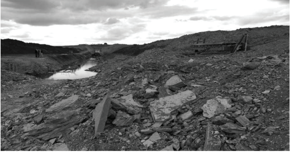
Şekil 4. Km 3+900 - km 3+980 arasında gelişen heyelan.
